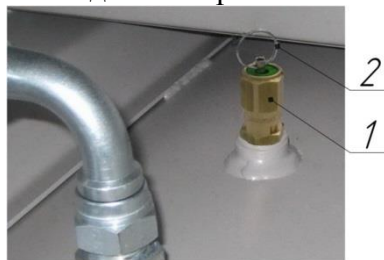
Рисунок 9 – Клапан предохранительный пружинного типа
